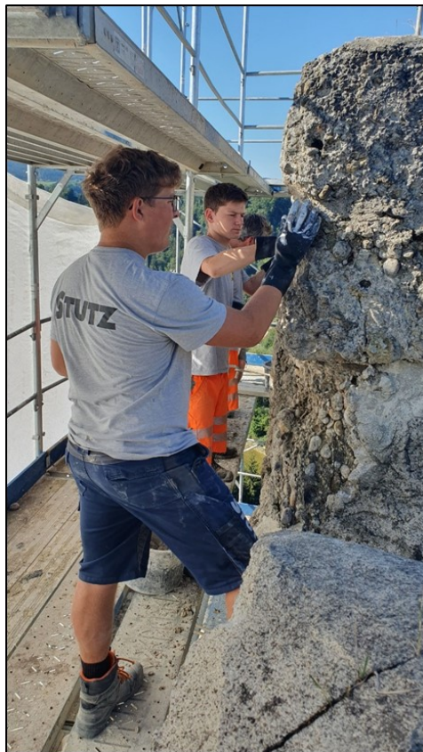
Für die Sanierungsarbeiten setzt die Firma Stutz AG auch Lehrlinge ein. Dank dem Einsatz der Lehrlinge können auch beträchtliche Kosten eingespart werden.
