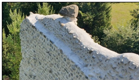
Das Bild zeigt den obersten Teil der sanierten Schildmauer mit dem wuchtigen Stein auf der Abdeckung.
