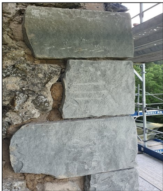
Die alten, morschen Sandsteine an den Ecken wurden entfernt und durch neue ersetzt.
